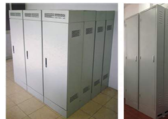
Tủ điện điều khiển
