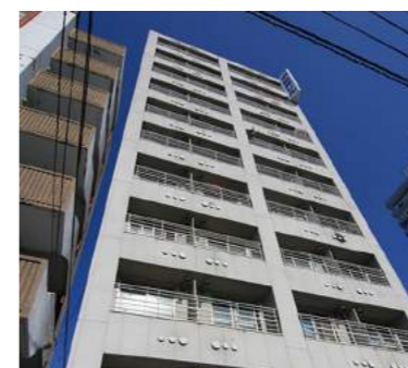
高級マンション Residential Mansion at Japan 乗用 | Passenger Elevator P9-600Kg-60m/min
