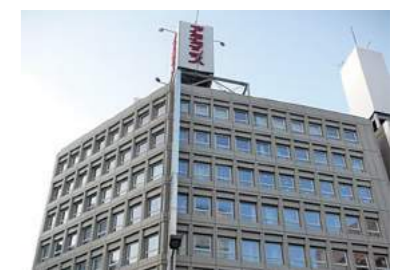
オフィスビル (大阪) Office Building at Osaka 乗用 | Passenger Elevator P11-750Kg-105m/min
